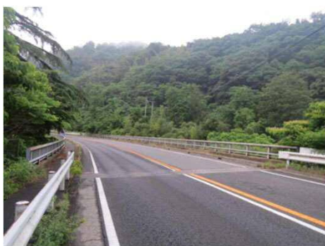
写真-1: 正面(起点より撮影)
