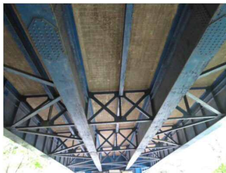
写真-2: 桁下(起点より撮影)
