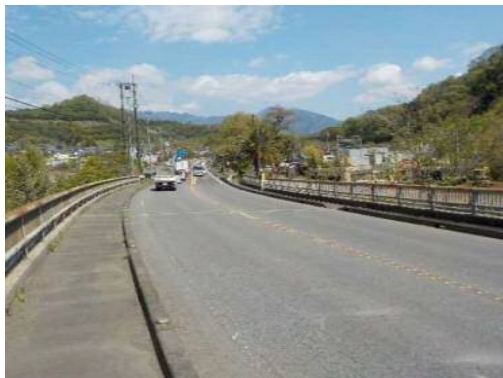
写真-8: 路面状況(起点より撮影)
